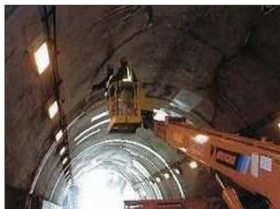
トンネル点検
