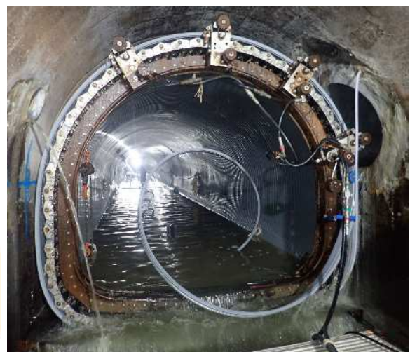
更生工法による幹線再構築
