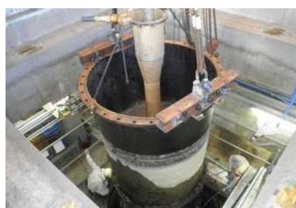
排水機場点検
