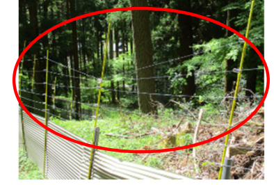
電気柵にゆがみが生じている箇所
