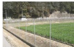
侵入防止柵の整備
