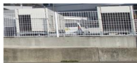
(電気設備の移設)
