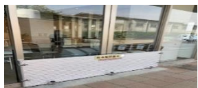
(止水板の設置)
