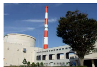
高速実験炉「常陽」
