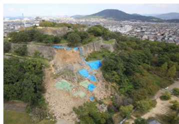
集中豪雨による石垣崩落 【史跡 丸亀城跡 (香川県丸亀市)】
