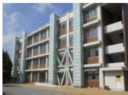
老朽改善された施設
