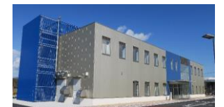
廃炉環境国際共同研究センター(CLADS)国際共同研究棟
