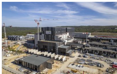
ITERサイトの建設状況
