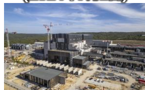
ITERサイトの建設状況
