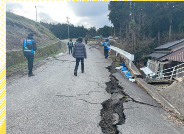
▲ ひび割れた道路を徒歩で孤立住宅訪問に向かうDPAT等合同チーム
