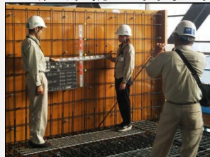
目視や手作業で鉄筋間隔等を測定
