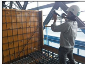
撮影画像から自動的に鉄筋間隔等を計測
