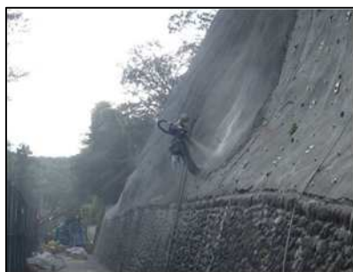
モルタル吹付工
