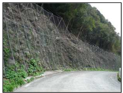
落石防止網工
