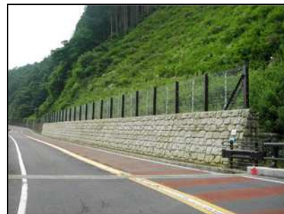
落石防護柵工
