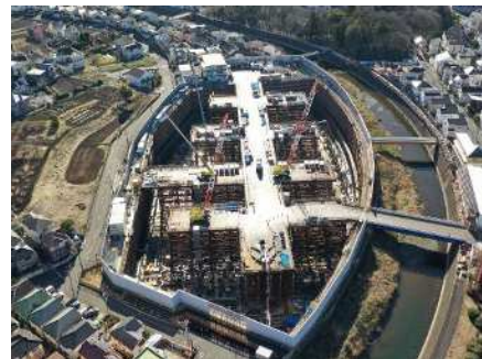
境川金森調節池整備状況
