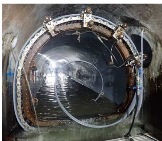
老朽化した下水道管の再構築
