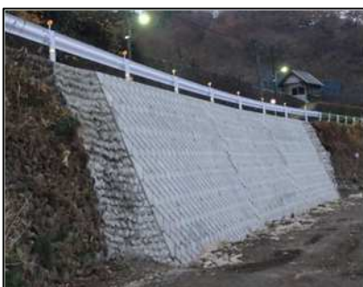
擁壁補強工（道路流失対策）
