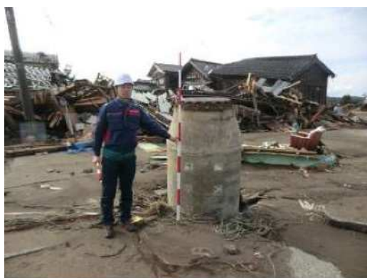
液状化による浮上（珠洲市）
