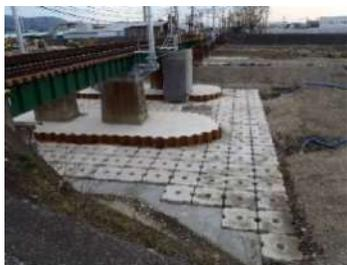
橋梁の流失・傾斜防止対策
