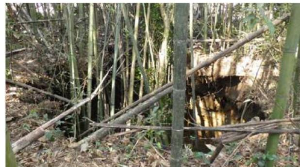
岐阜県の斜坑直上の地上部において、直径8m、深さ5m程度の崩落事故が発生
