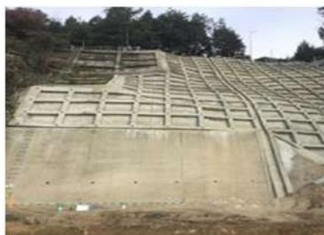
斜面の崩壊防止対策
