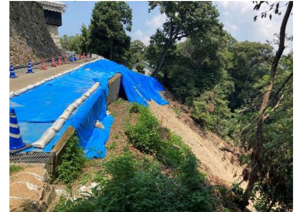
史跡松山城跡 （愛媛県松山市） 令和6年7月豪雨による斜面崩落被害
