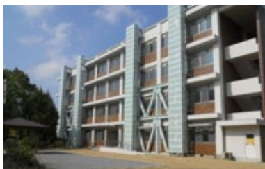
老朽改善された施設
