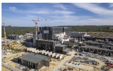
ITERサイトの建設状況
