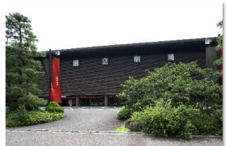
閉場中の国立劇場
