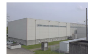
JT-60一次冷却棟
