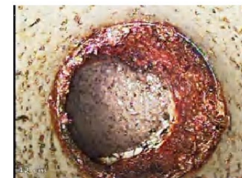
配管の詰まり、排水管の腐食
