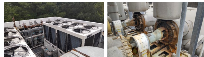
理化学研究所の空冷式チラーの更新
