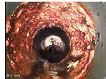
配管の詰まり、排水管の腐食
