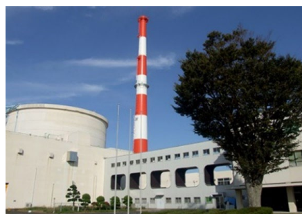
高速実験炉「常陽」
