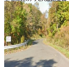
工場周辺のアクセス道路整備
