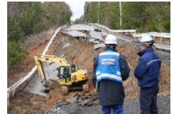
▲建設業者と連携した道路の緊急復旧
