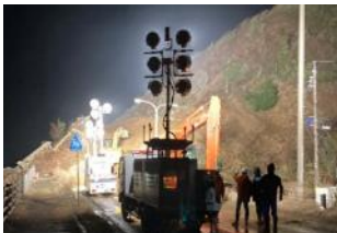
▲照明車を活用した昼夜を徹した道路の緊急復旧
