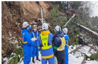
▲TEC-FORCEによる被災状況調査
