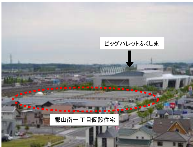
郡山市南一丁目仮設住宅遠景
